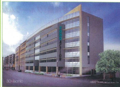
鉄筋コンクリートコア+グルーラム軸組工法の6階建て建物(CSN FondAction)
