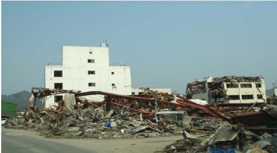
津波が襲った地域。鉄筋コンクリート造の建築物も基礎ごと倒壊している。
