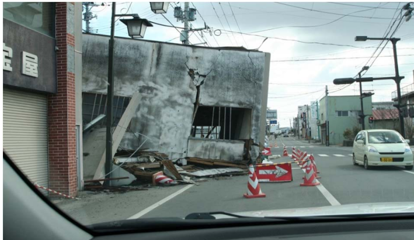
津波の被害はなかったものの、震度6強を記録、地震の揺れ、地盤沈下等により被災。
